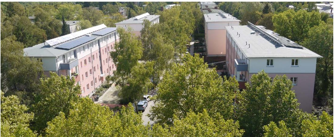
Das ausgeklügelte Energiekonzept ermöglicht bilanziell eine komplett regenerative Wärmeversorgung trotz der vergleichsweise kleinen solarthermischen Fläche von circa 2,5 m<sup>2</sup> pro Wohneinheit
