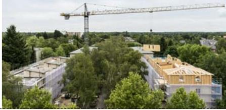
Die vorgefertigten Holzbauteile lassen sich in wenigen Tagen auf der Baustelle montieren
