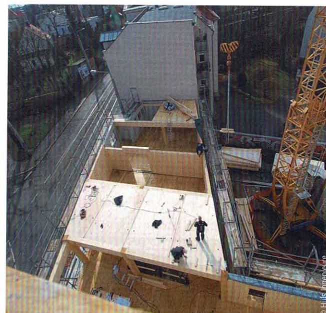
Abb. 10: Die BSP-Deckenelemente wurden zwischen die BS-Holzträger eingefügt und an den Längsstößen zu Scheiben verbunden.
