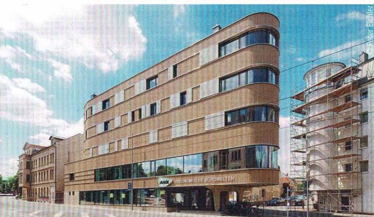
Abb. 1: Das fünfgeschossige Z8 in Leipzig vereint Gewerbe und Wohnen in einem außergewöhnlich geformten Holzbau. Die Fassade mit ihren horizontalen Bändern aus Fenstern, Schiebeläden und der vorvergrauten Lärchenholzbekleidung prägt den Charakter des Gebäudes.
