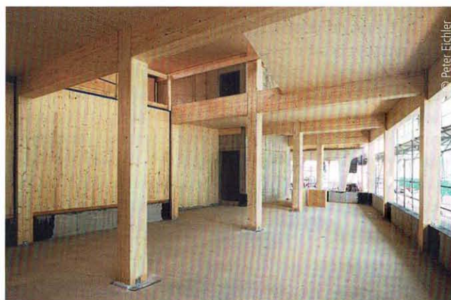
Abb. 6: ... als auch im EG. BSP-Decken und -Wände bilden aussteifende Scheiben, die wie in Rahmen jeweils zwischen die Träger und geschosshohen Stützen eingefügt sind. Nur die Stützen um das interne Treppenhaus zwischen EG und 1. OG sind zweigeschossig ausgeführt.
