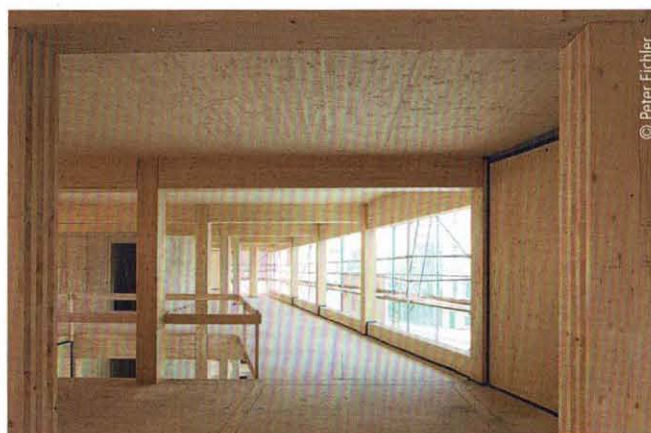
Abb. 5: Das Holzskelett aus BS-Holzstützen und dazwischen gehängten Trägern ist einfach ablesbar. Sowohl im 1. OG ...
