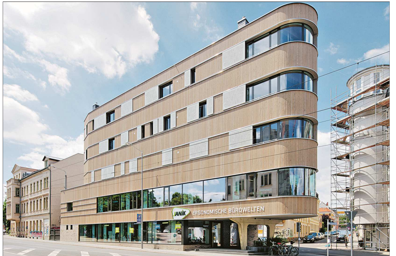
Das fünfgeschossige Z8 in Leipzig vereint Gewerbe und Wohnen in einem außergewöhnlich geformten Holzbau. Die Fassade mit ihren horizontalen Bändern aus Fenstern, Schiebeläden und der vorvergrauten Lärchenholzbekleidung prägt den Charakter des Gebäudes.
