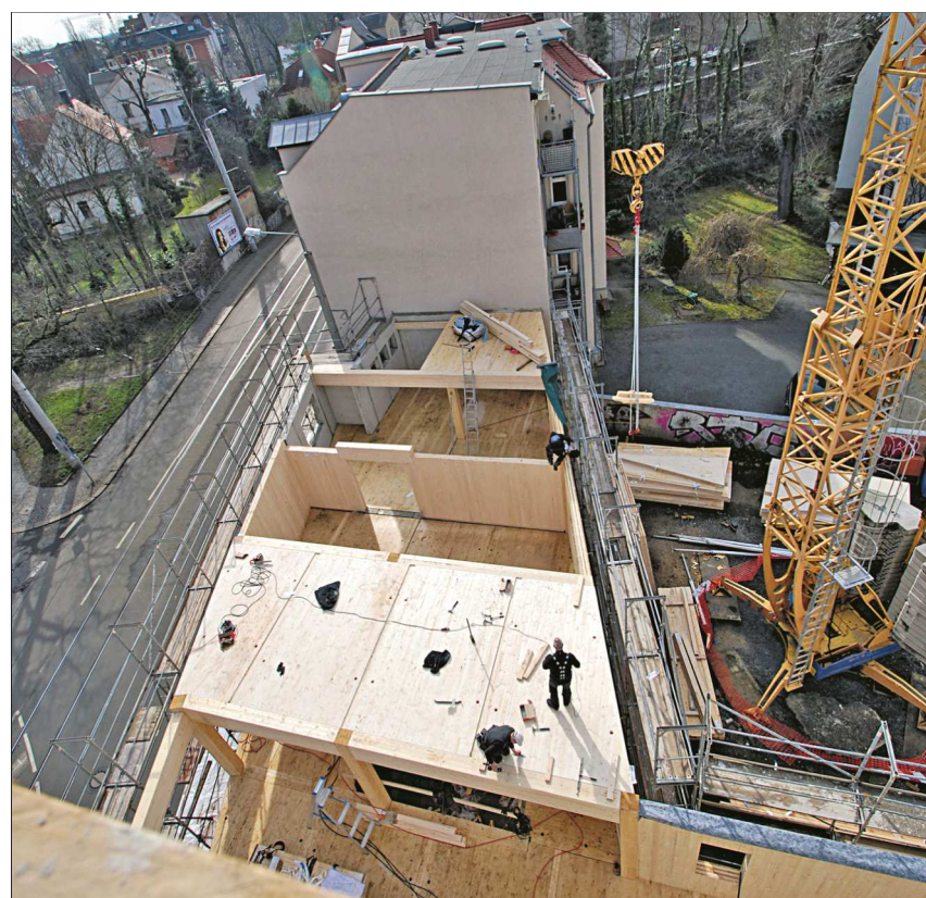
Die BSP-Deckenelemente wurden zwischen die BSH-Träger eingefügt und an den Längsstößen zu Scheiben verbunden. Foto: Hüls Ingenieure
