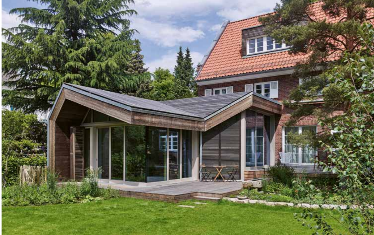
STEFAN MÜLLER/HS-ARCHITEKTEN HIRSCHMÜLLER SCHINDELE GBR
